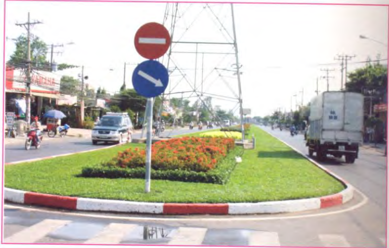
Đường Trần Nãi
