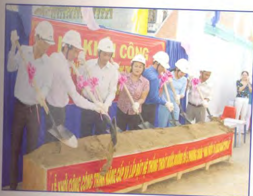
Khởi công đường số 5 phường Thạnh Mỹ Lợi
